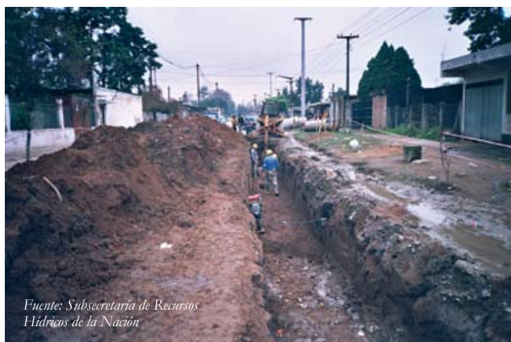
Tendido de cañerías de los desagües cloacales de San Miguel de Tucumán. 2005
