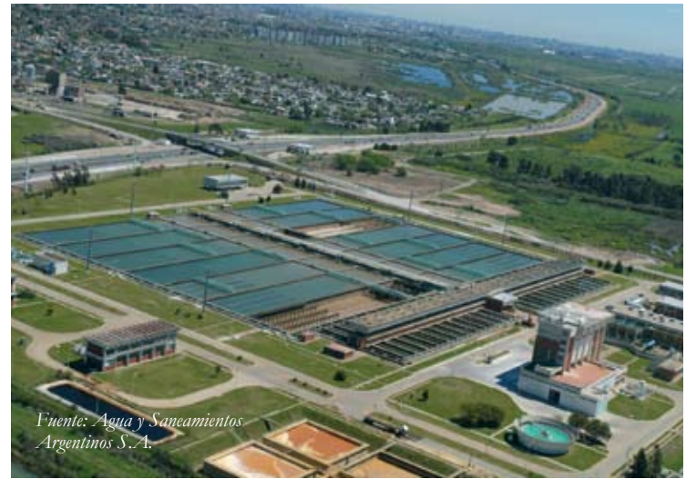
Planta Depuradora General Belgrano. Bernal. Buenos Aires
