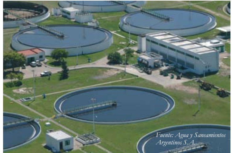
Planta Depuradora Norte. El Tigre. Buenos Aires
