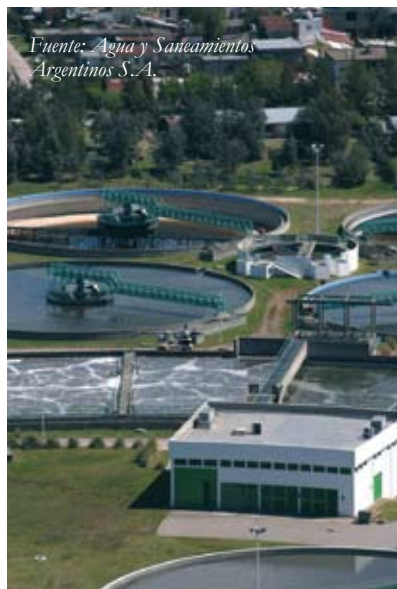
Planta Depuradora Norte, El Tigre, Buenos Aires
