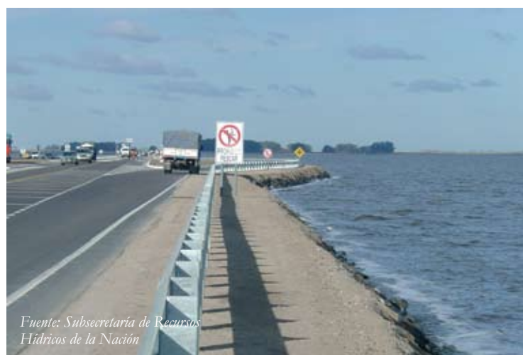
Obra de Alteo de la Ruta Nacional N°7. Santa Fe
