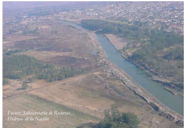
Control de inundaciones. Canalización del Río Salado en Junín. Buenos Aires
